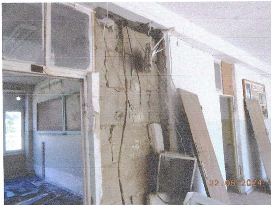
Նկ. 3 Շրջանակների սյուների ու պարզունակների միացման հանգույցներում տարանջատման ճաքերի տեսքը
